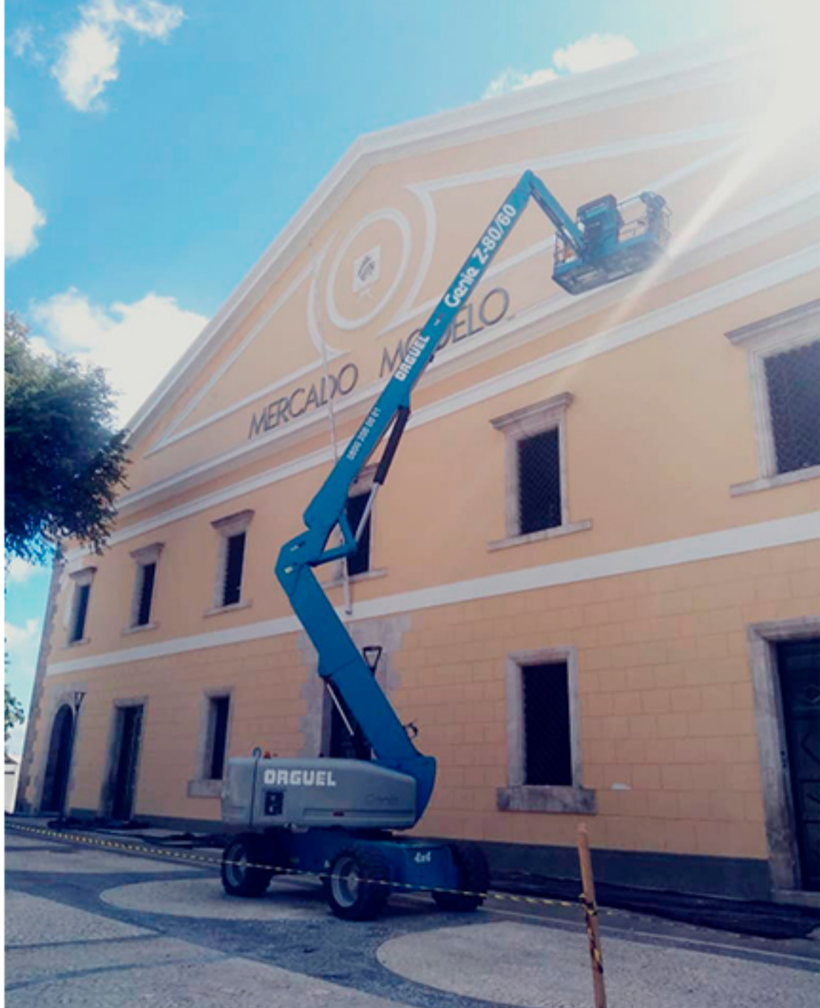
Lança articulada Genie® Z-80/60 da Orguel, trabalhando na manutenção do Mercado Modelo em Salvador, Bahia
