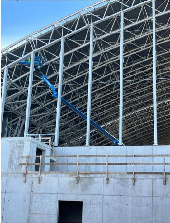
Il braccio jib articolato di Genie ha reso la macchina ideale per il montaggio delle strutture in acciaio in spazi ristretti.
