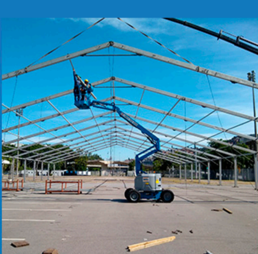
Mills Solaris na construção de hospital de campanha - Rio de Janeiro, RJ
