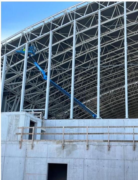
Le pendulaire articulé de la nacelle Genie l'a rendue idéale pour travailler sur la charpente métallique en espaces restreints.
